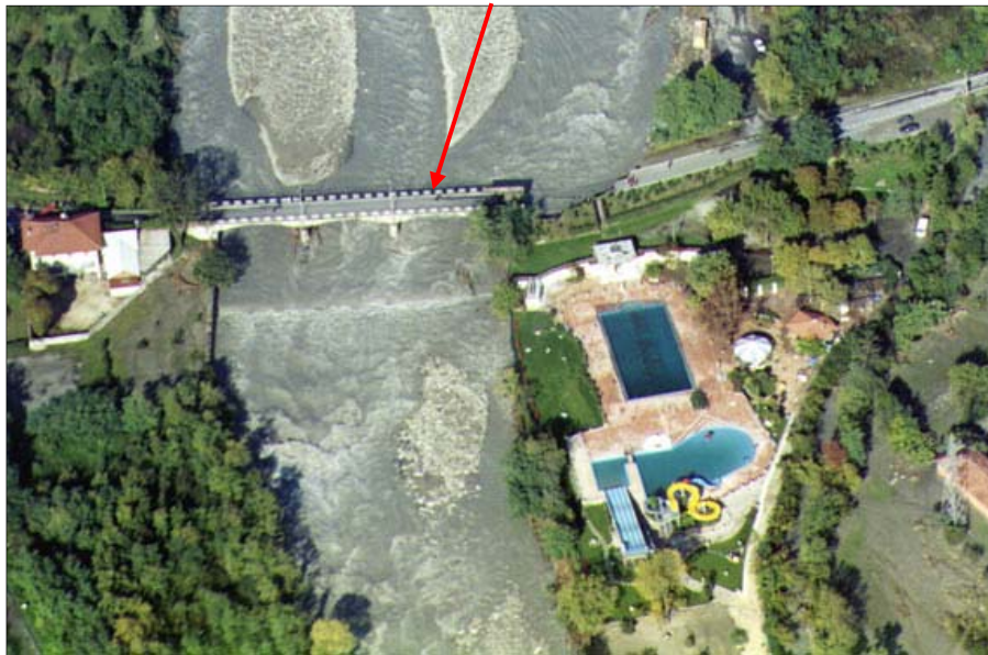
Fig. 3.1: esempio di fenomeno di instabilità morfologica e relativo danno associato
